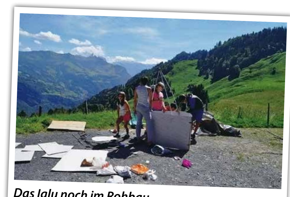
Das Iglu noch im Rohbau
