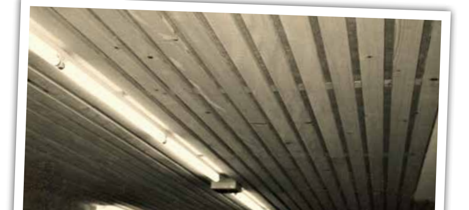
Erst 1984 werden zwei Zivilschutzräume in der Turnhalle in Fronarbeit isoliert und mit Holz getäfert. Zweck: Dorfwerkstatt.
