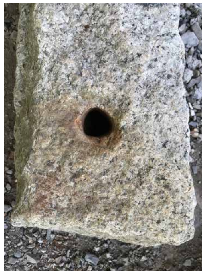
Ein Loch wird eingebohrt.
