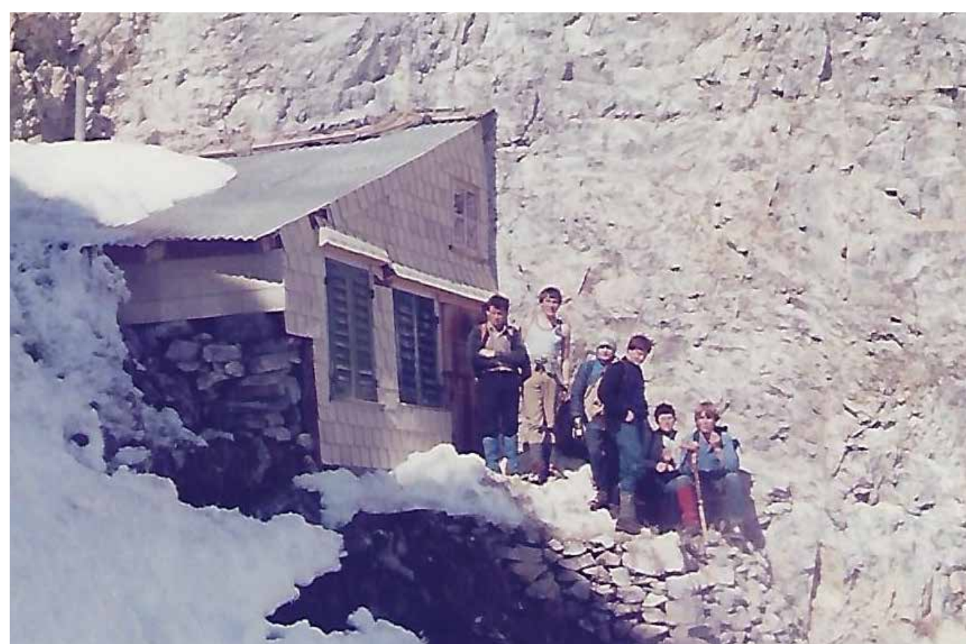
Geissbalmhütte von 1986. Die Vorgängerhütte war eine ganz einfache Baracke.
